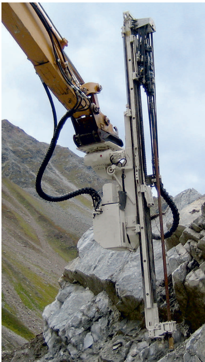
Blast hole drilling with HDA RE BF Sprenglochbohrungen mit HDA RE BF
