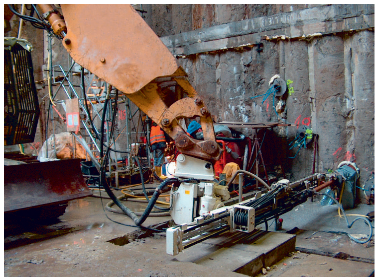
Ground stabilization with HDA RE Baugrubensicherung mit HDA RE
